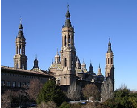
Zaragoza: Basilica del Pilar
